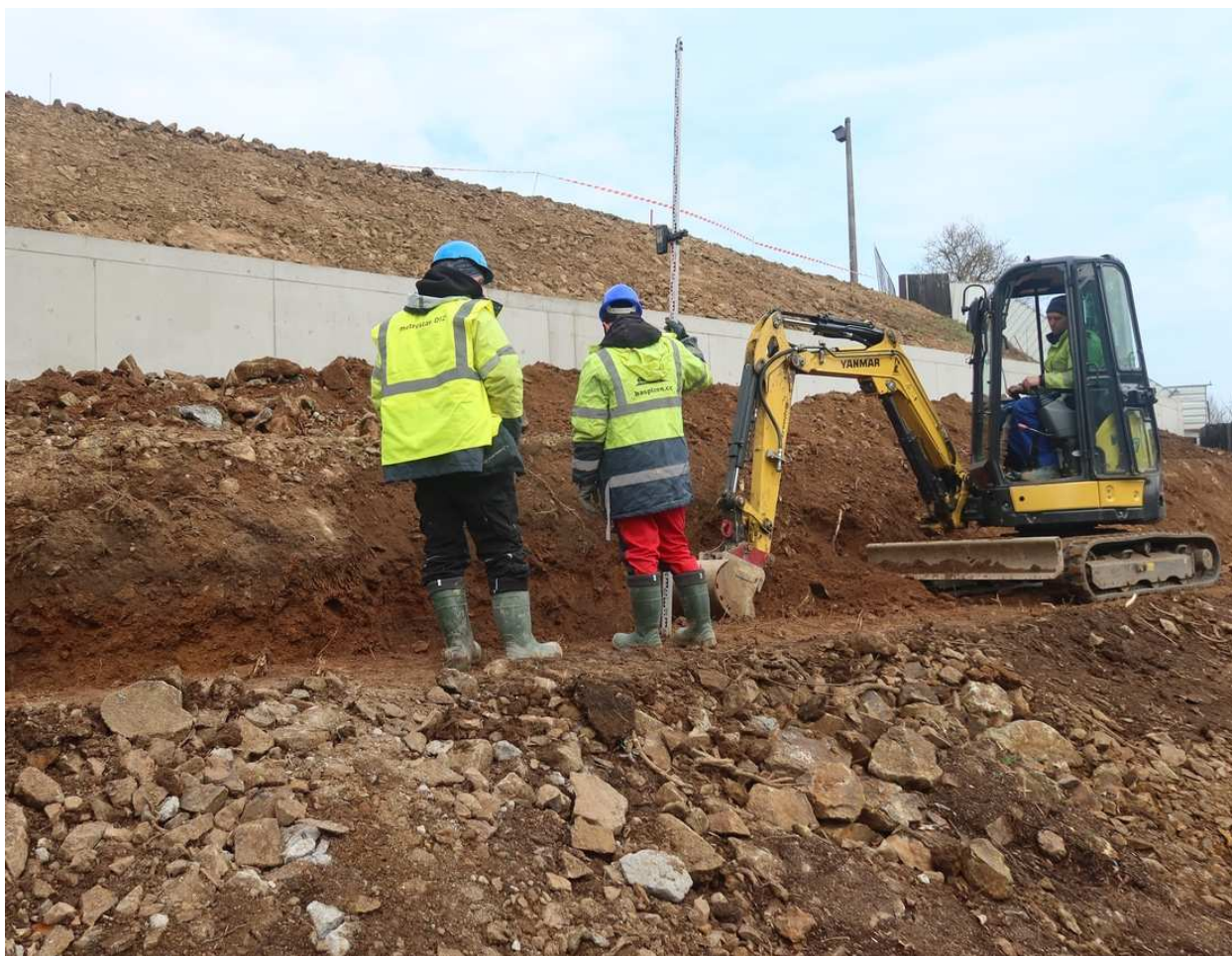
Zemní práce pro základy voliér – objekt SO04.
